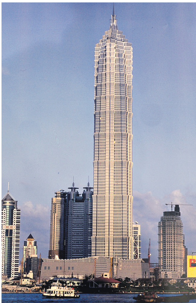
Det amerikanske arkitektfirma SOM har gennemført over 10.000 projekter i 50 lande - som Jin Mao Tower i Shanghai.
